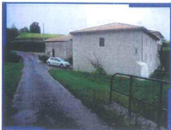
7. "Beauregard": Limite de la zone inondable au droit du virage
