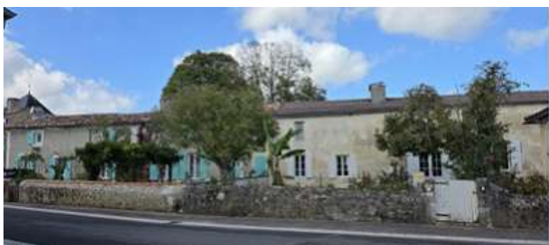
Fig 1 : l'ancien prieuré dans le bourg (route des Châteaux)
