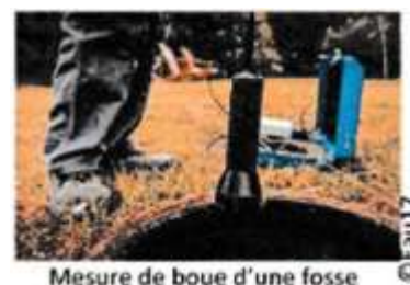
Mesure de boue d'une fosse
