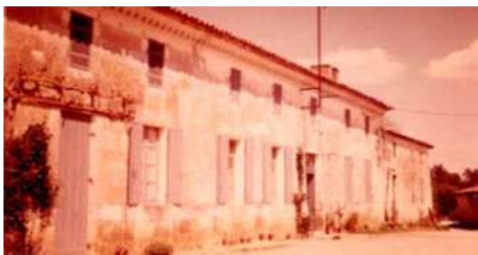
Fig 7 : ancienne maison Duvedeix à Massicot
