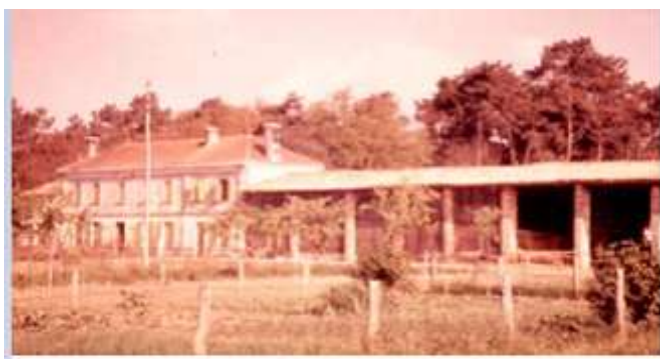
Fig 8 : maison Mornet à Souillac
