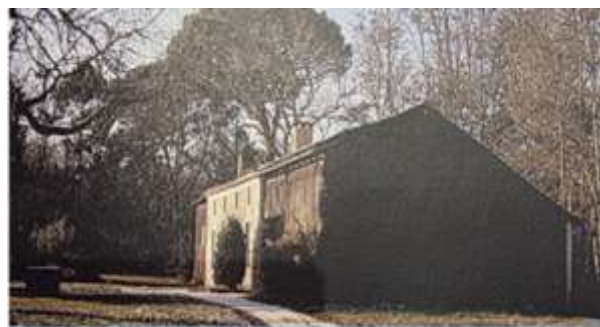
Fig4 : la maison du Taillis au milieu du XXème siècle
