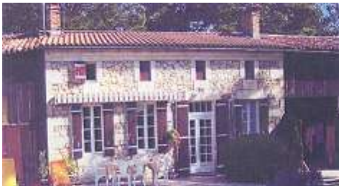
Fig 3 : la maison du Taillis juste avant sa démolition suite à la construction de la LGV
