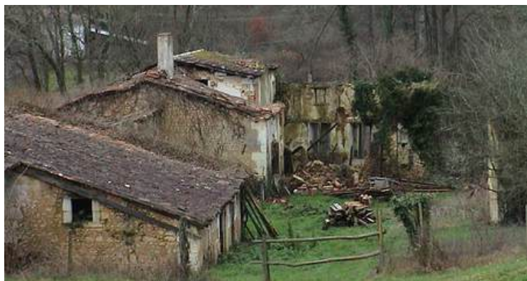
Façade Nord de l'aile subsistante (début 2000)
